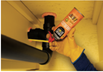
Penetraciones de tuberías
